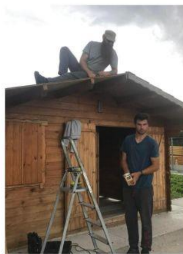
L'installation a été le prétexte à un chantier d'insertion : électriciens, menuisiers, les professionnels se sont engagés à employer des jeunes.
