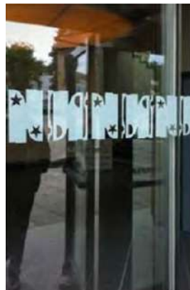
Illustration 11: Signalétique sur paroi vitrée
